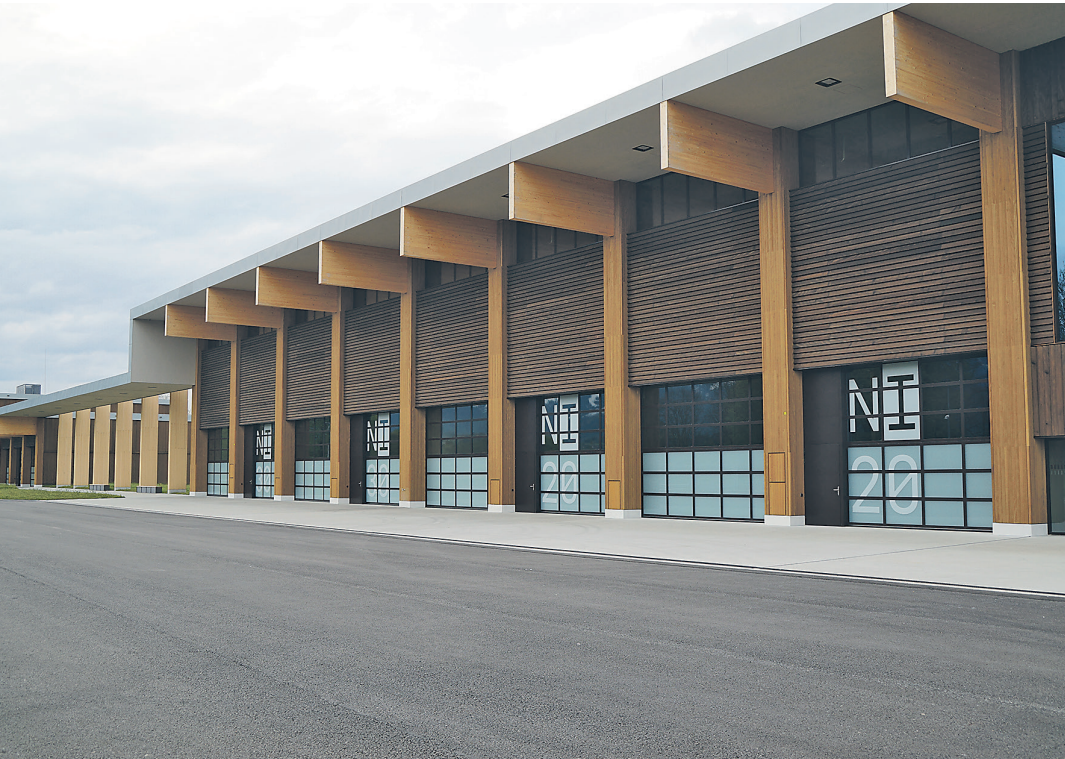
Die neue Ausbildungshalle der Schweizer Armee auf dem Thuner Waffenplatz ist eines der grössten Holzbauwerke der Region. Die dafür benötigte Holzmenge wächst im Schweizer Wald in nur drei Stunden und 30 Minuten nach.
