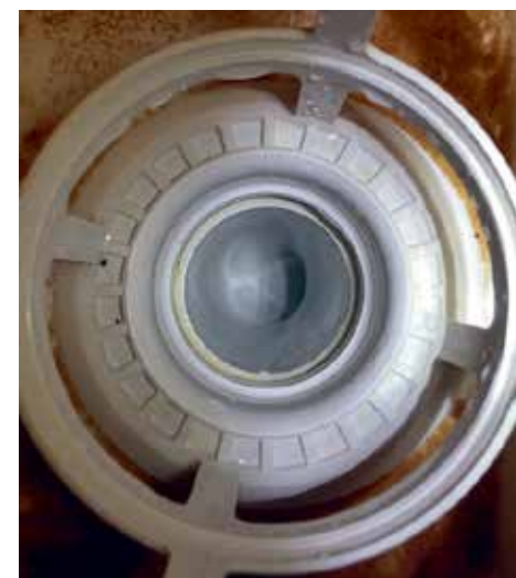
Entkalktes Spülrohr nach Service.
